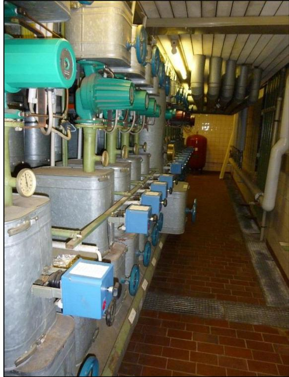
**ABBILDUNG 16: HEIZKREISVERTEILUNG AUS DEM
