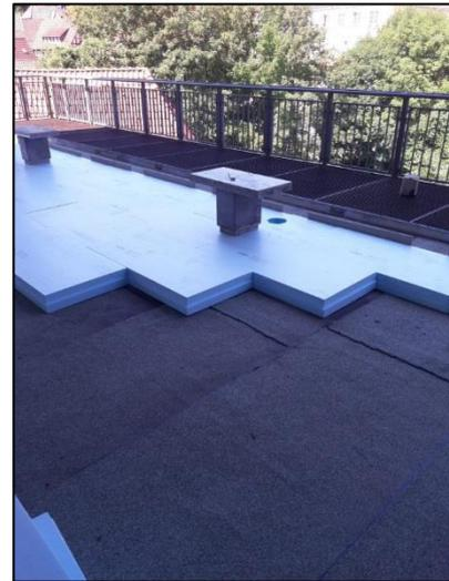
**ABBILDUNG 13: VERLEGUNG DER DRUCKFESTEN EPS-DÄMMUNG IM LUFTGESCHOSS**
