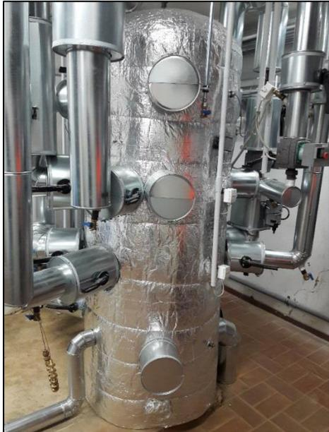
**ABBILDUNG 12: NEUER HEIZKREISVERTEILER**
