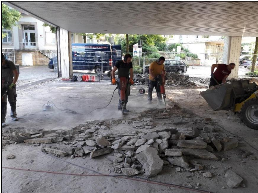
**ABBILDUNG 14: ZUR ENTFERNUNG DES VERBUNDESTRICHS WURDEN ÜBER WOCHEN 30 KG SCHWERE PRESSLUFTHÄMMER EINGESETZT**
