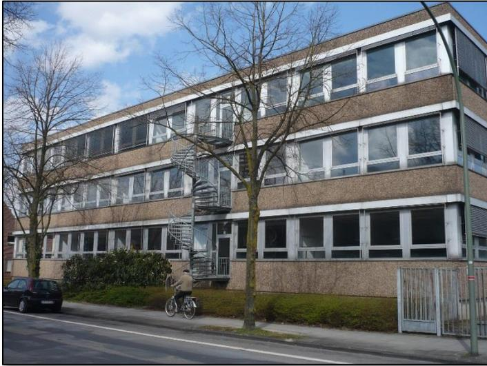
**ABBILDUNG 8: BLICK VON DER SPRICKMANNSTRASSE AUF DAS GEBÄUDE F MIT DER SEIT 1972 UNVERÄNDERTEN FASSADE UND DEN FENSTERBÄNDERN**
